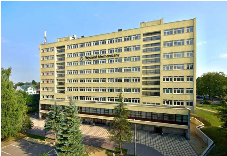
Budynek Wydziału Mechanicznego Politechniki Lubelskiej
